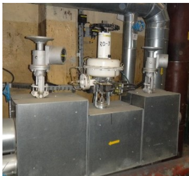
Zdjęcie 1. RO-3 zawór automatycznej regulacji ciśnienia i zrzutu recyrkulacji
