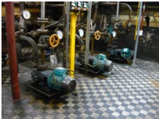
Zdjęcie 13. Zespół pomp PT1-3 podających olej turbinowy z zbiorników ZOT na bloki B1-8
