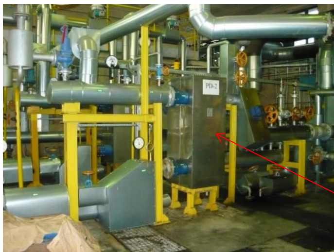
Zdjęcie 7. Widok instalacji podgrzewania mazutu podgrzewacz
