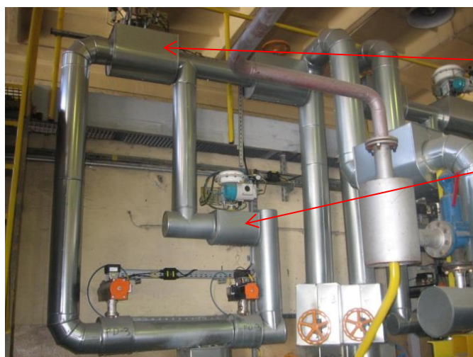
Zdjęcie 8. Widok instalacji parowej dla potrzeb zasilania podgrzewaczy płytowych PD1-3
