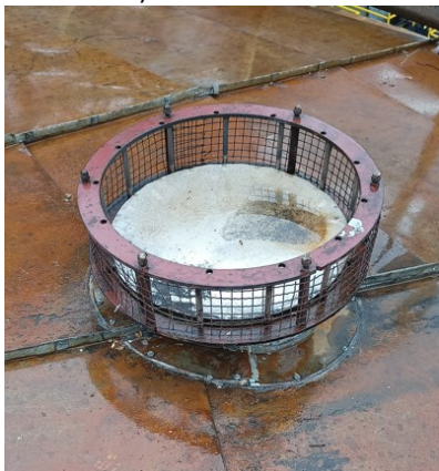
Zdjęcie 29. Zawór bezpieczeństwa nadciśnienia na zbiorniku ZOM-1
