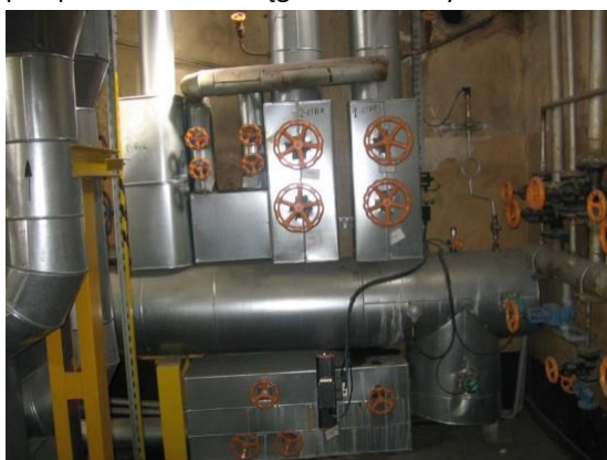
Zdjęcie 2. Kolektor pary z I i II etapu dla potrzeb podgrzewaczy mazutu i instalacji parowej p.poż.
