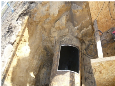
Zdjęcie 14. Usunięcie nieszczelności rurociągu D_n 800 przez wspawanie łaty na powierzchni dolnej rurociągu przez tzw. okno
