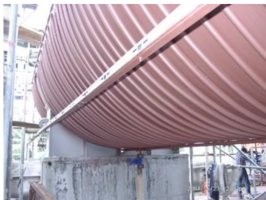
Zdjęcie 12. Widok zewnętrznej nagrzewnicy parowej płaszcza zbiornika oleju ZOT
